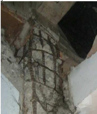
Gambar 8. Kerusakan yang terjadi pada struktur kolom yang tidak monolit
