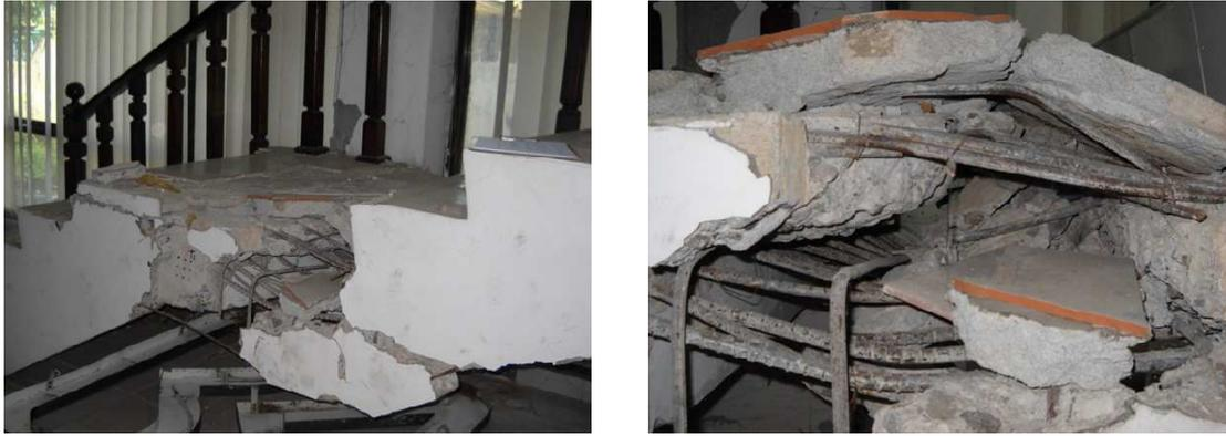
Gambar 7. Kerusakan yang terjadi pada struktur tangga
