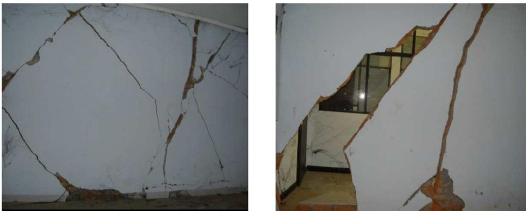
Gambar 2. Tipikal kerusakan non-struktural yang terjadi pada dinding bata lantai 1
