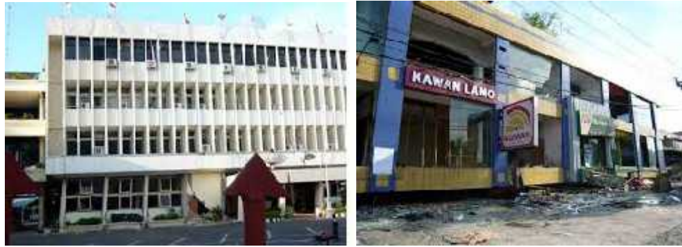
Gambar 1. Kerusakan bangunan akibat soft story saat Gempa Sumbang 30 September 2009.
