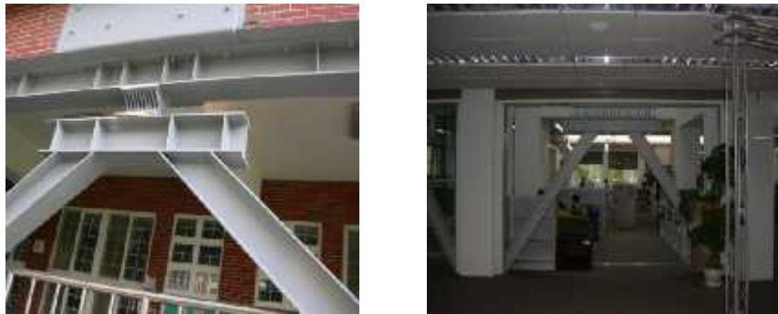
Gambar 3. Contoh penggunaan metallic damper pada gedung.
